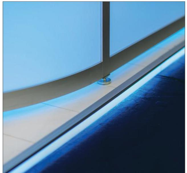
Laminatboden mit hinterleuchteter Abschlusskante
